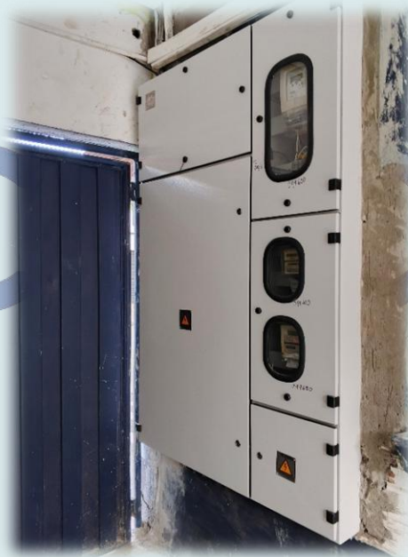
Mejoramiento sistema eléctrico, cambio de gabinete de distribución de energía interna
