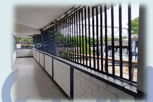
Intervención riesgo locativo, segundo piso, rejas de seguridad.
