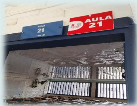
Cielo raso salón 21
