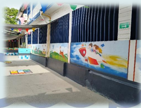
Mantenimiento Pintura Preescolar
