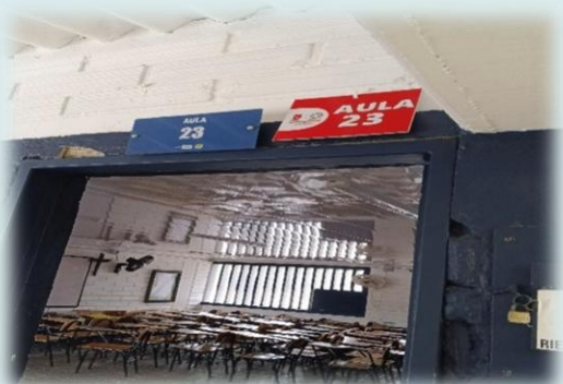
Cielo raso salón 23
