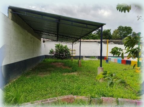
Pared y techo parque preescolar
